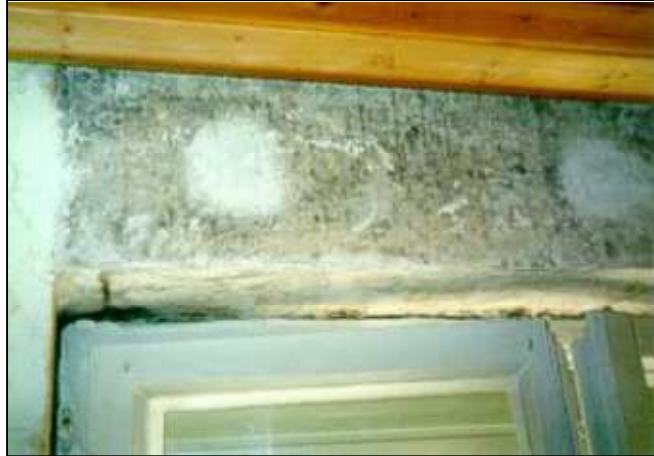
Figura 1.6 – Muffa nascosta sul lato freddo dell'isolante interno, applicato con punti singoli di malta (diapositiva del corso base di WUFI ® , Fraunhofer IBP).
