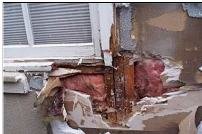
Figura 1.9 – Infiltrazioni di acqua piovana alle spalle dell'isolamento a cappotto di una parete, in corrispondenza di un davanzale (diapositiva del corso base di WUFI ® , Fraunhofer IBP).
