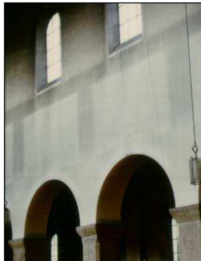
Figura 1.3 – Alterazioni cromatiche sull'intonaco di una struttura in calcestruzzo, in una chiesa, dovuti alle differenti condizioni di umidità superficiale (diapositiva del corso base di WUFI ® , Fraunhofer IBP).
