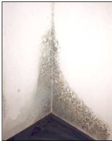
Figura 1.4 – Crescita microbiologica dovuta alle temperature superficiali basse negli angoli (diapositiva del corso base di WUFI®, Fraunhofer IBP).
